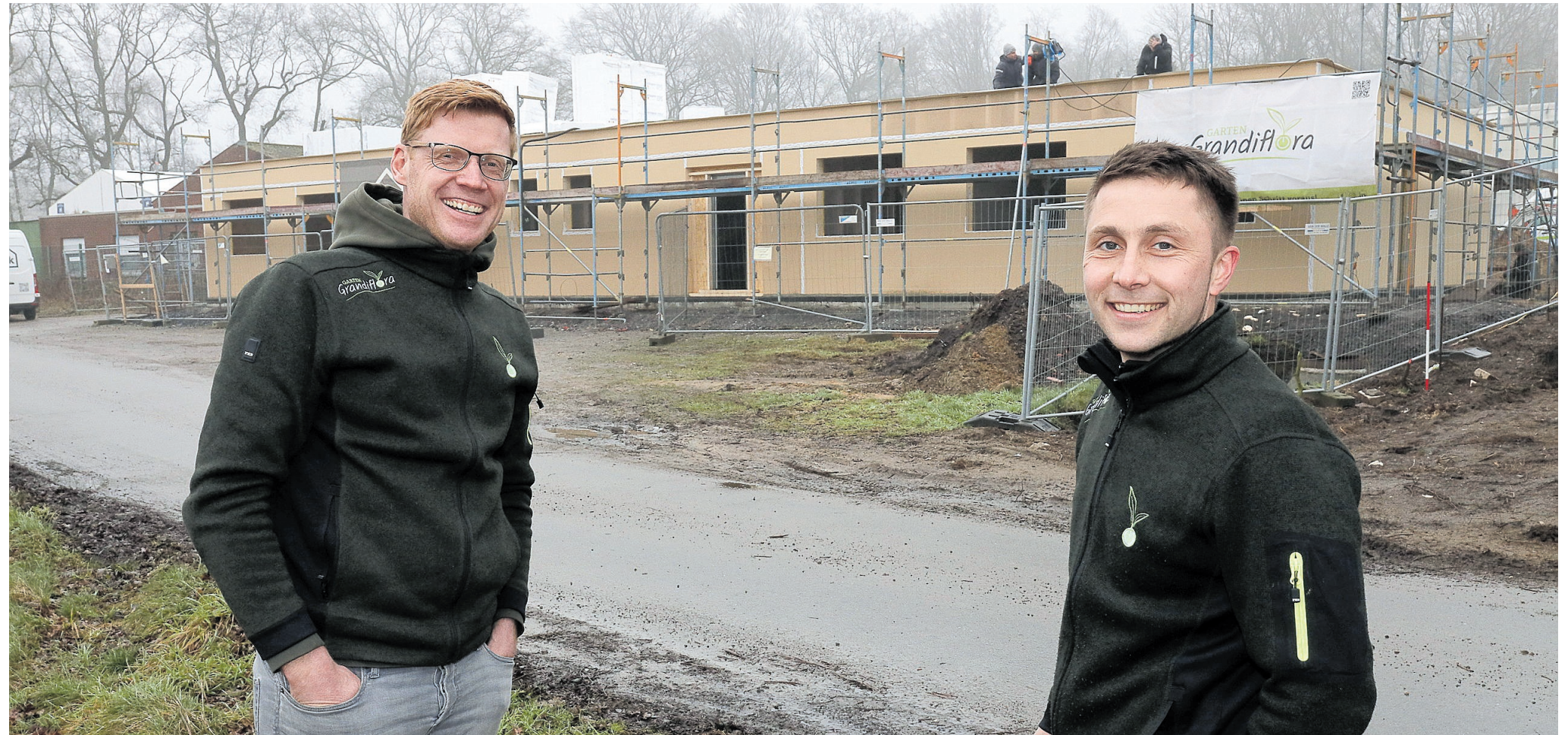
Johannes Telaar und David Zimmermann vor dem Rohbau am neuen Firmensitz im Bocholter Süden..
